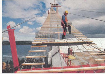
Arbete med catwalk våren 1996.
